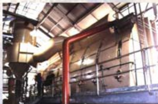
Tacho continuo 'High Grade' de 150 m3 - Australia
