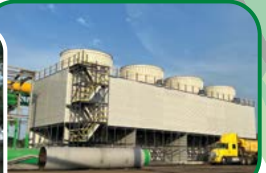
Ingenio San Pedro, Lerdo de Tejada, Ver. Torre de contra-flujo, armada en campo
