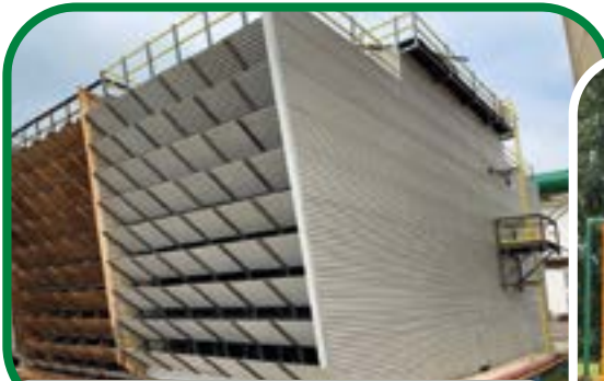
Ingenio Tres Valles, Tres Valles, Ver. Torre de flujo cruzado, armada en campo
